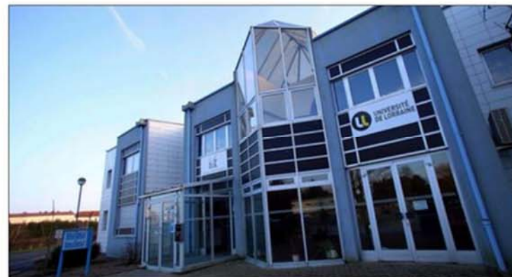
Les bâtiments A1, A2 et Génie électrique et informatique industrielle (GEII) vont faire l'objet d'une rénovation. Photo archives RL/Samuel MOREAU
